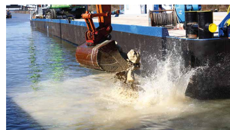
Einbringen der neuen Steinschüttung
