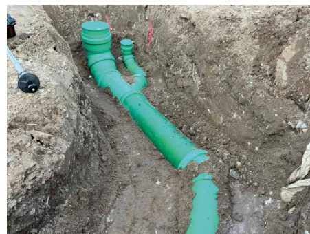
Durchaus eine Herausforderung: Der Einbau des Rohrsystems in teils felsigem Baugrund
