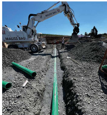
Auch bei diesem Großprojekt überzeugte das KG2000-System durch seine besonders einfache und schnelle Verlegung
