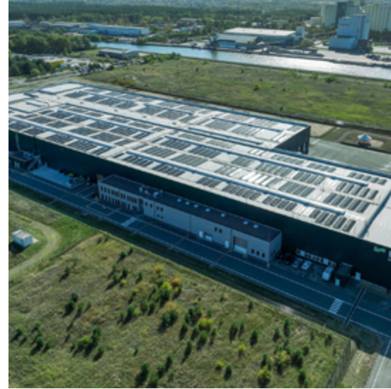
Produktionsgelände des Holzmodulwerks von timpla by Renggli
